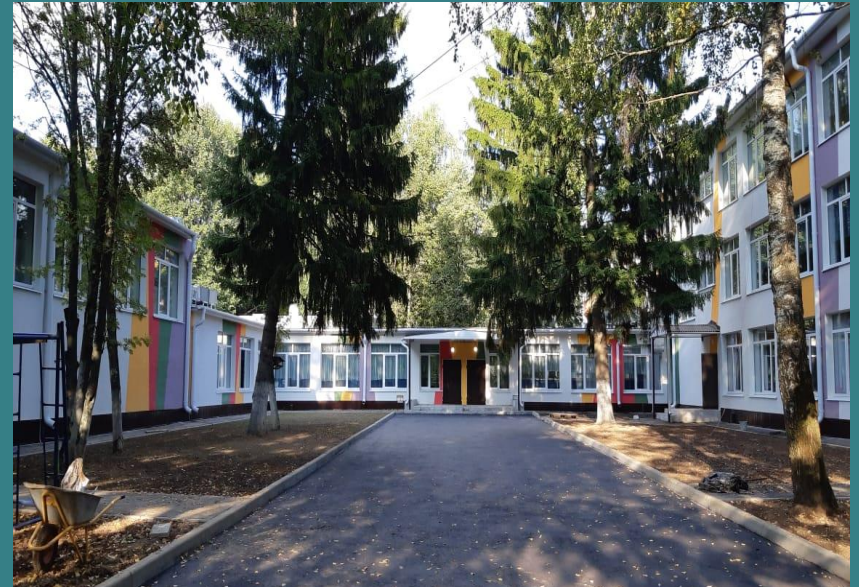
Капитальный ремонт школы МАОУ "Белостолбовская СОШ", мкр. Белые Столбы, ул. Авенариуса, д. 11»
