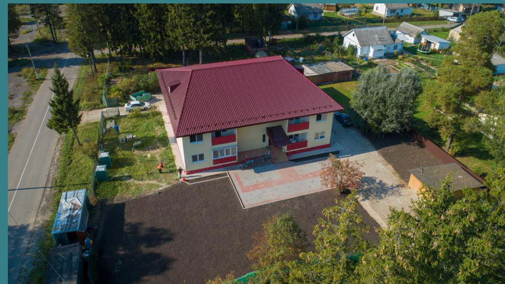
Ремонт жилого дома (после пожара) тер. Городок-15, д.1а
