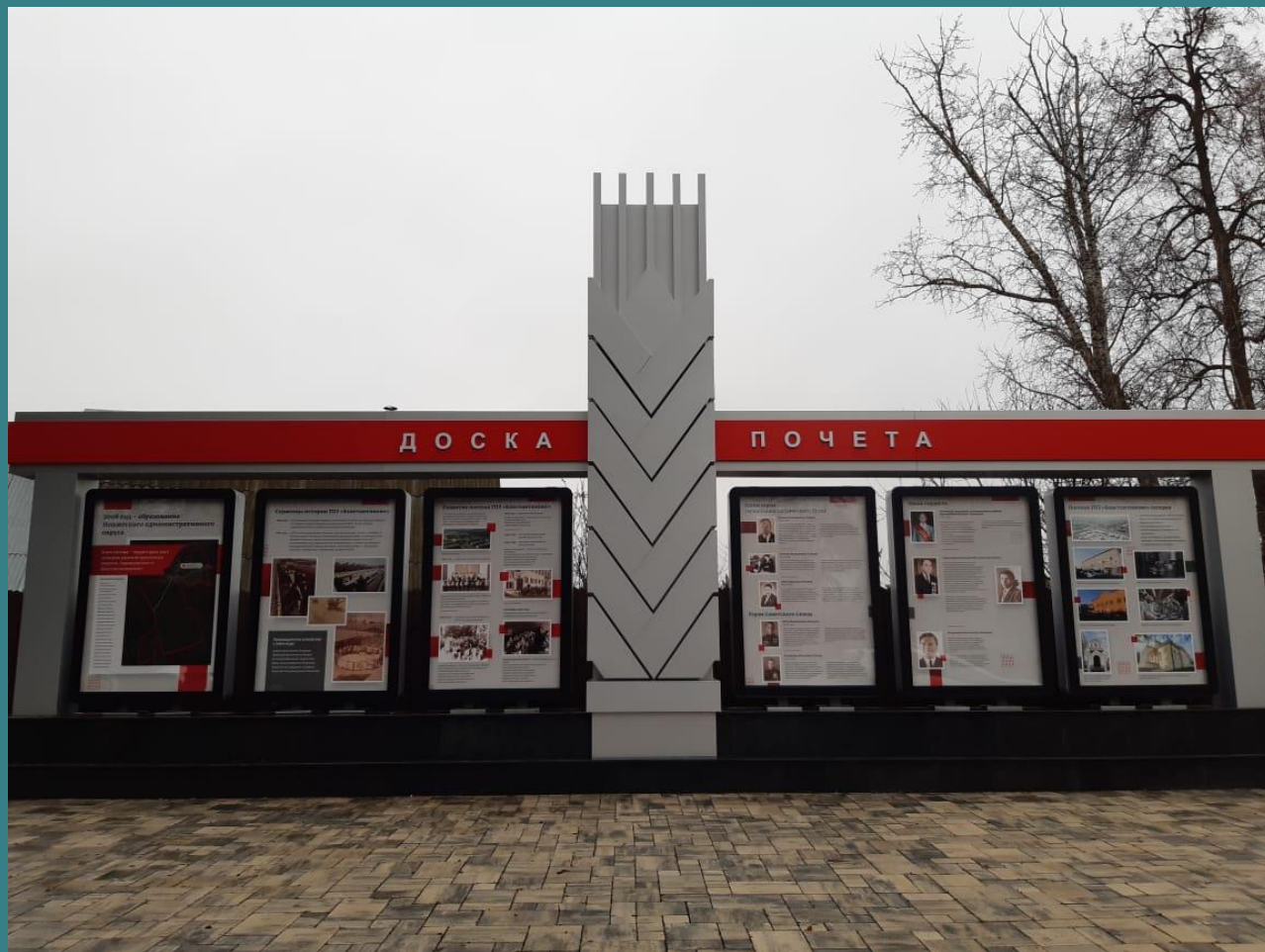
Изготовление и монтаж доски почета, ГПЗ Константиново, ул. Центральная, д. 1
